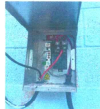
REPARACION DE SISTEMA ELECTRICO
