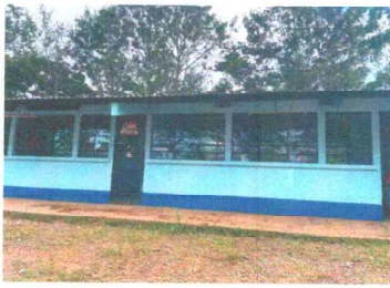
PINTURA EN MUROS INTERIOR Y EXTERIOR
