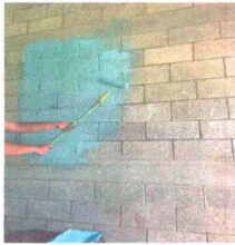
PINTURA EN MUROS INTERIOR Y EXTERIOR
