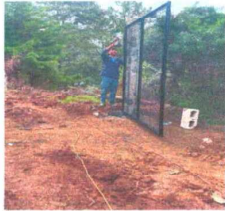
MANTENIMIENTO A PORTONES
