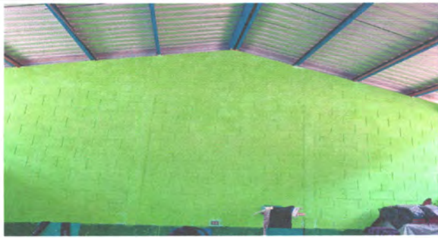
Foto3: PINTURA EN MUROS INTERIOR Y EXTERIOR
