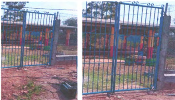
Foto: 5 MANTENIMIENTO A PORTONES
