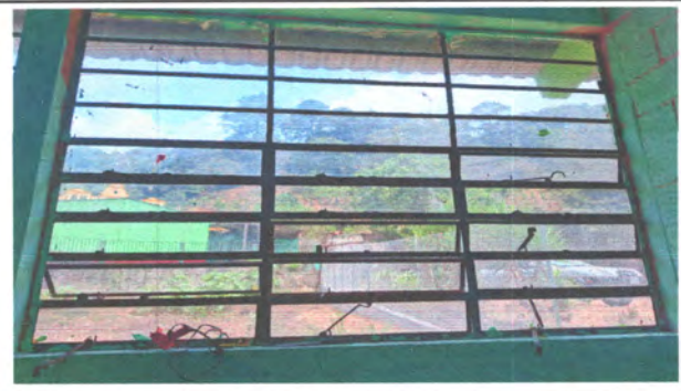
FOTO 2: REPARACION DE VENTANAS
