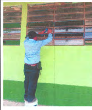
FOTO 2: REPARACION DE VENTANAS
