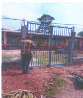
Foto: 5 MANTENIMIENTO A PORTONES
