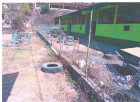
FOTO 8: SUSTITUCIÓN DE MURO PERIMETRAL
