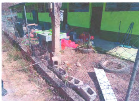
Foto: 5 MANTENIMIENTO A PORTONES
