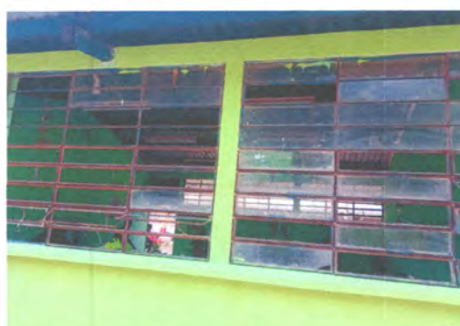
FOTO 2: REPARACION DE VENTANAS
