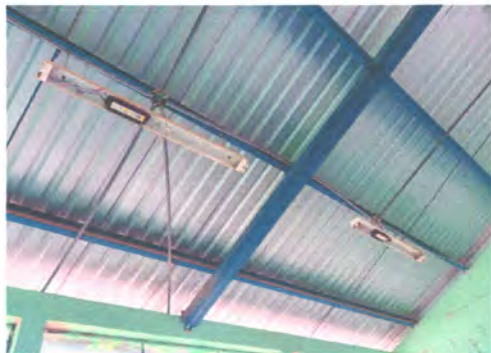
Foto 7: REPARACION DE SISTEMA ELECTRICO
