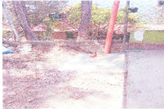
Foto4: Reparación de drenaje
