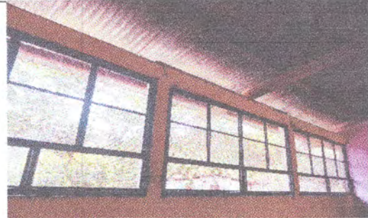
FOTO 2: Sustitución de 23 ventanas
