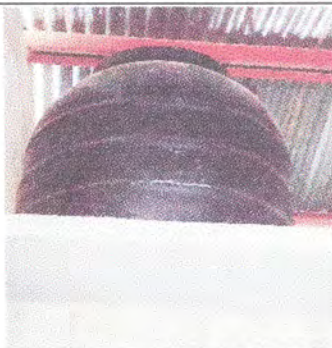
Foto: 5 sustitución e instalación de deposito de agua
