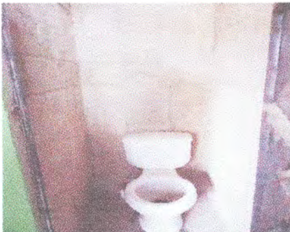
Foto3: Reparación de sanitarios y sus accesorios
