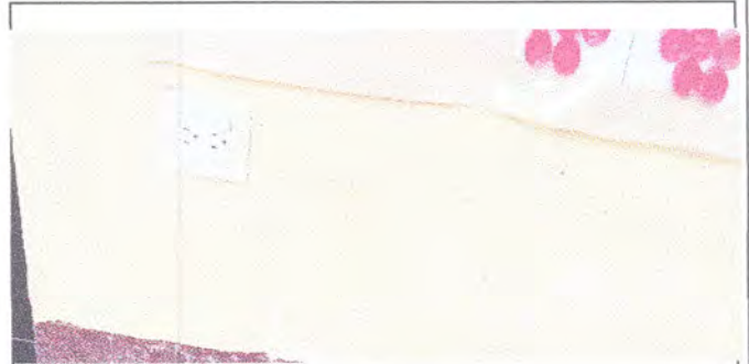
Foto: 6 reparacion de sistema electrico
