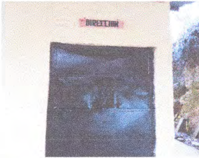
Foto1: reparación de puertas
