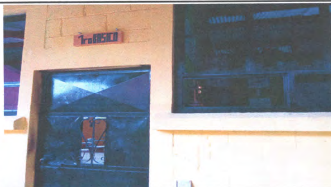
Foto1: reparación de puertas
