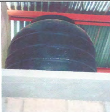
Foto: 5 sustiución e instalación de deposito de agua
