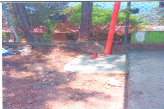
Foto4: Reparación de drenaje
