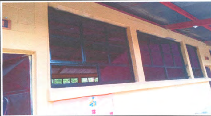
FOTO 2: Sustitucion de 23 ventanas
