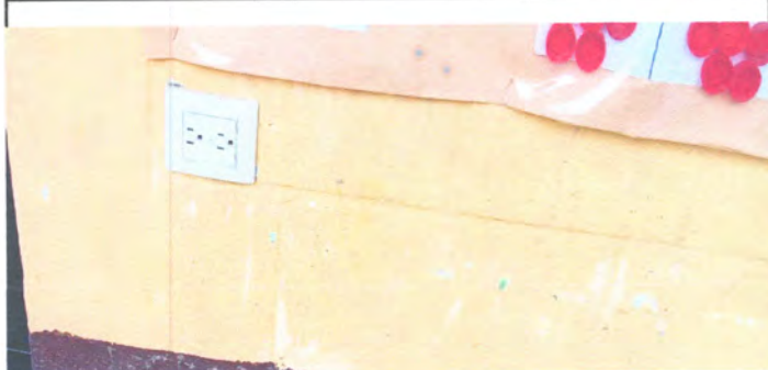
Foto: 6 reparacion de sistema electrico
