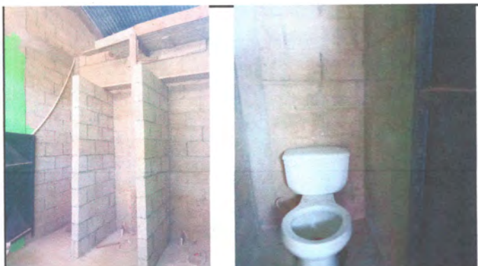
Foto3: Reparación de sanitarios y sus accesorios
