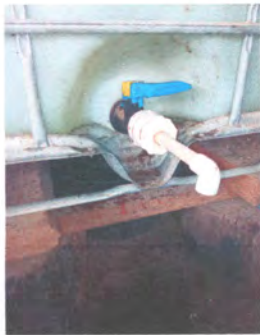
Foto: 5 sustiución e instalación de deposito de agua
