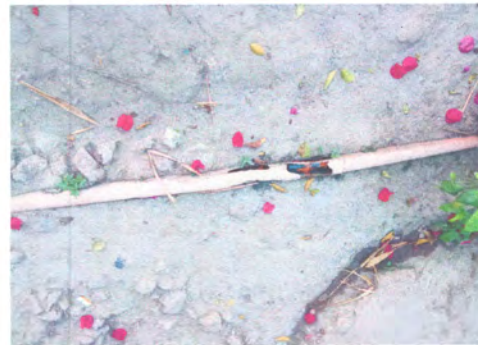
Foto4: Reparación de drenaje
