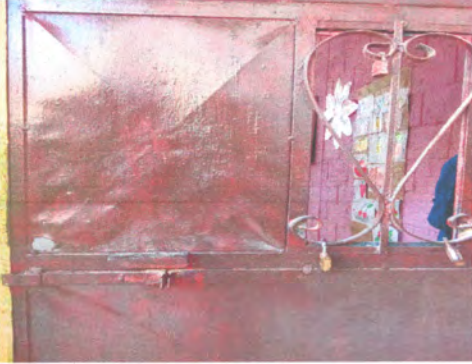
Foto1: reparación de puertas
