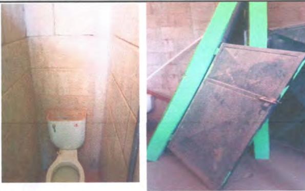
Foto3: Reparación de sanitarios y sus accesorios
