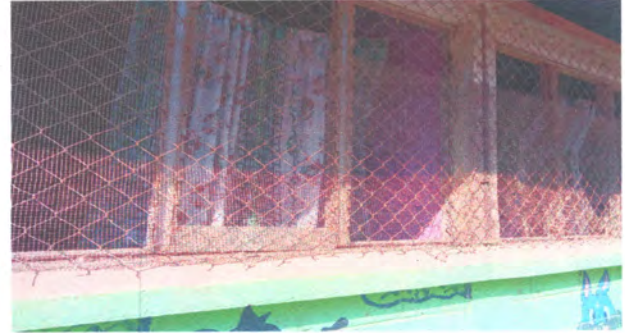
FOTO 2: Sustitucion de 23 ventanas
