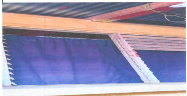
Foto: 6 sustitución de ventanas
