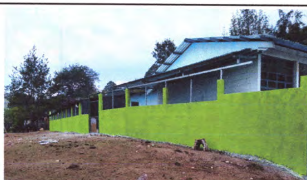
FOTO 4: Pintura de muros exterior e interior finalizado.
