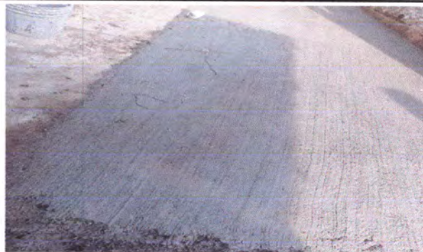
FOTO 6: Reparación de la losa del patio de la escuela finalizado.
