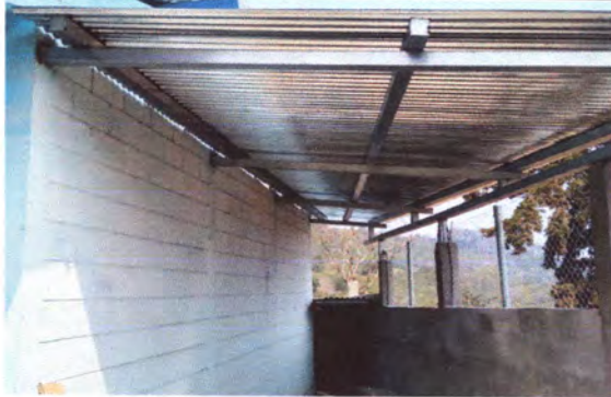
FOTO 1: Sustrucción de cubierta de lamina finalizada.
