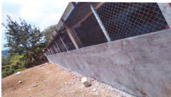
FOTO 7: Reparación del muro perimetral de la escuela finalizado.
