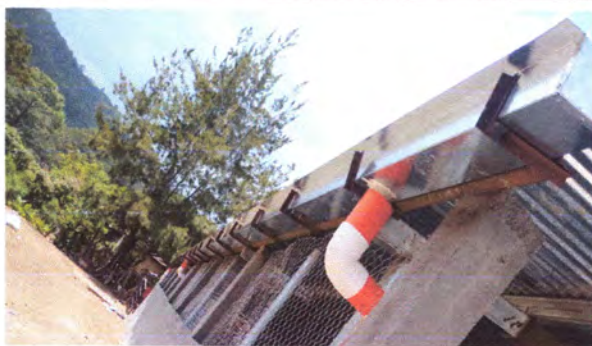
FOTO 5: Sustrucción de canales y tubería de caídas de agua
