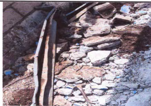
foto 6: Reparacion de la losa del patio de la escuela en proceso.
