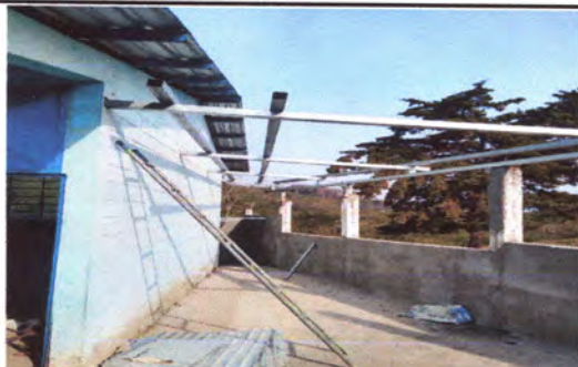
FOTO 1: Sustrucción de techo en proceso.
