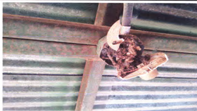
FOTO8: REPARACION DEL SISTEMA ELECTRICO DE LA ESCUELA.
