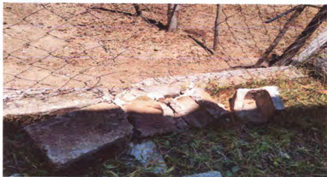
Foto7: REPARACION DEL MURO PERIMETRAL DE LA ESCUELA.
