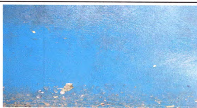
Foto4: PINTURA DE MUROS, EXTERIORES,INTERIORES,
