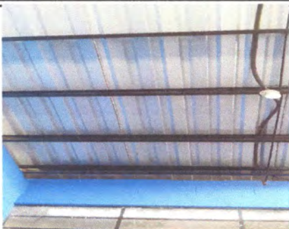
Foto1: TECHO NUEVO DEL EDIFICIO
