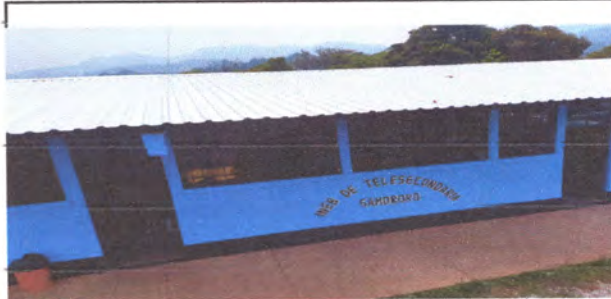
Foto 2: PINTURA Y TECHO DE SANITARIOS
