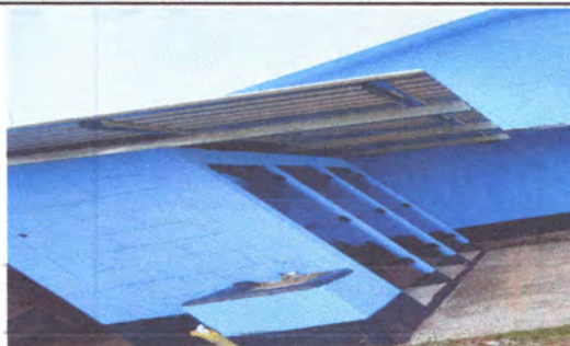
Foto 2: PINTURA Y TECHO DE SANITARIOS
