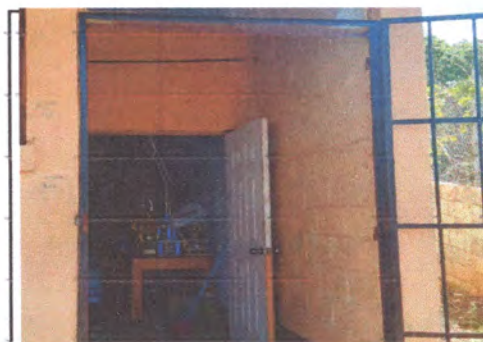
Foto 6: CAMBIO PUERTAS DE AULAS
