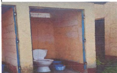
Foto 4: CAMBIO PUERTAS DE SANITARIOS
