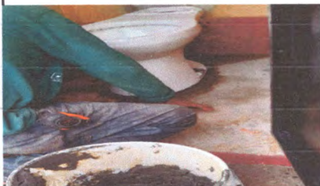
Foto 3: CAMBIO DE SANITARIOS
