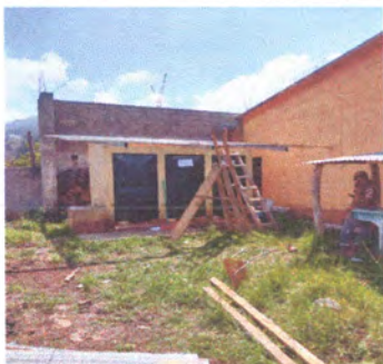
Foto 1: CAMBIO DE TECHO DE SANITARIOS
