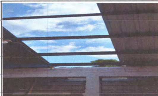
Foto 2: CAMBIO DE TECHO DE EDIFICIO ESCOLAR
