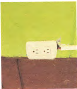
Foto1: Reparación de cableado electrico y cambio de tomacorrientes
