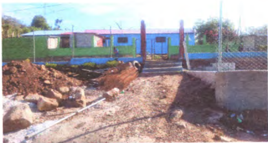
Foto4: Sustitución de Losa de Patio pues se encuentra casi en su totalidad deteriorada
