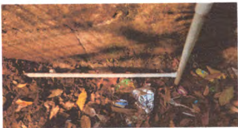
FOTO 2: Reparación de tuberías a sanitarios dañados
