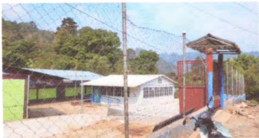
Foto3: Sustitución de maya para cerco perimetral
