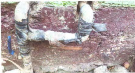
Foto4: Sustrucción de Losa de Patio pues se encuentra casi en su totalidad deteriorada
