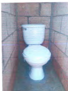
Foto: 5 Reparación y mantenimiento a sanitarios
