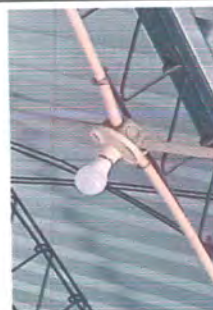
Foto 10: Reparación de sistema eléctrico
