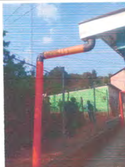
Foto 4: Reparación de canales
