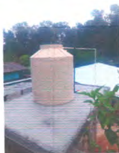
FOTO 8: Reparación y mantenimiento de cisterna de agua
