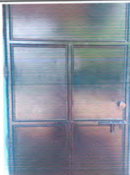
Foto3: Mantenimiento de puertas
