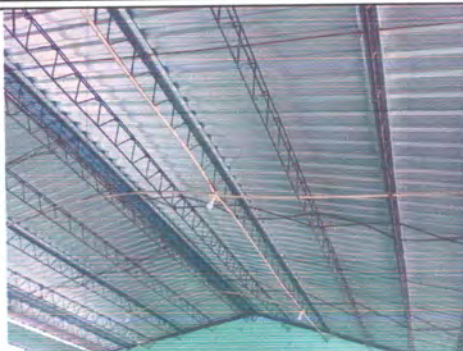
FOTO 2: Reparación estructura de techo
