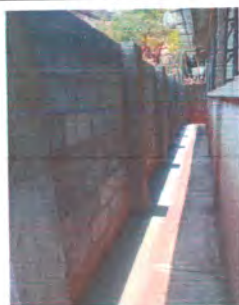
Foto 9: Reparación y ampliación de muro de contención
