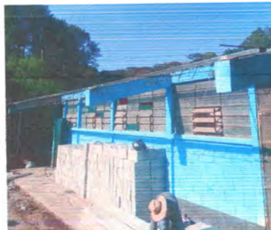
FOTO 2: Reparación estructura de techo
