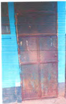
Foto3: Mantenimiento de puertas
