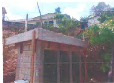
Foto 8: Reparación y mantenimiento de cisterna de agua
