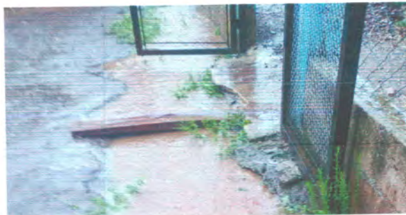
Foto: 6 Reparación y mantenimiento de portón
