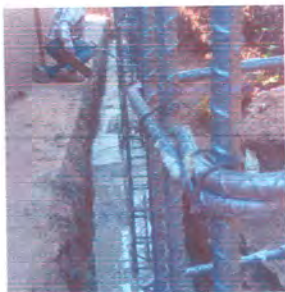
Foto 9: Reparación y ampliación de muro de contención
