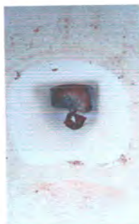
Foto: 5 Reparación y mantenimiento a sanitarios
