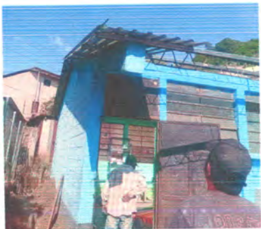
Foto1: Sustrucción de lamina por deterioro
