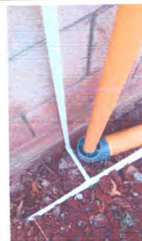
Foto 4: Reparación de canales
