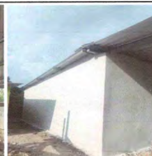
Foto 4: Reparación de repello y cernido en paredes
