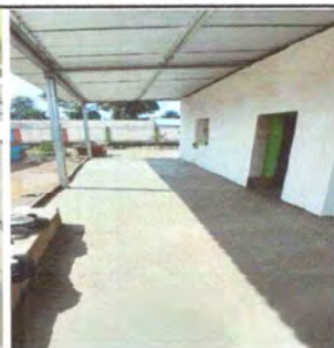
Foto 3: Sustrucción de piso de cocina ya que se encontraba muy quebrado
