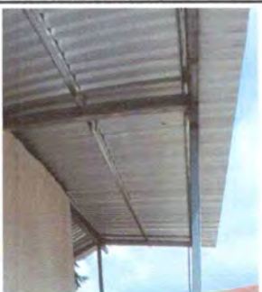
Foto 1: Sustrucción de cubierta de lamina en cocina
