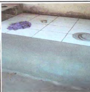
Foto 6: Sustrucción de piso en area de planchas de cocina
