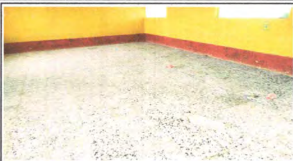
Foto 7: Sustrucción de piso en aula, ya que hay un hundimiento en todo el piso
