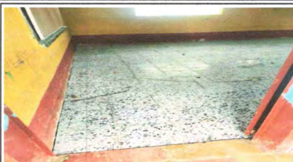
Foto 8 : Sustrucción de piso en aula ya que hay un hundimiento en todo el piso
