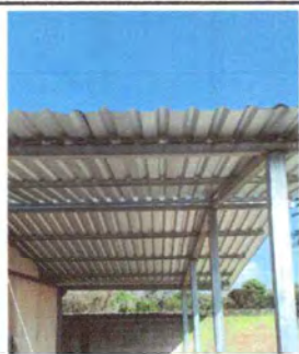
Foto 1: Sustrucción de cubierta de lamina en cocina
