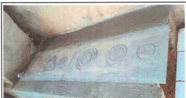
Foto 5: Sustrucción y reparación de planchas de cocina
