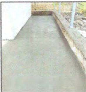
Foto 3: Sustrucción de piso de cocina ya que se encontraba muy quebrado
