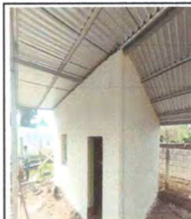
Foto 4: Reparación de repello y cernido en paredes
