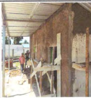
Foto 4: Reparación de repello y cernido en paredes
