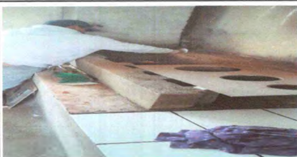
Foto 5: Sustrucción y reparación de planchas de cocina
