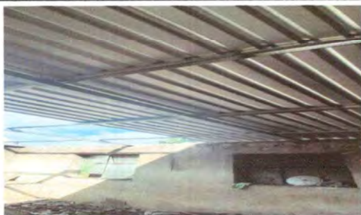
Foto 1: Sustrucción de cubierta de lamina en cocina
