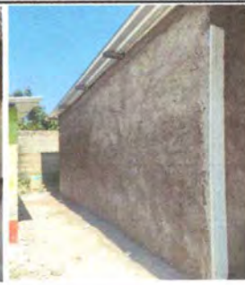
Foto 4: Reparación de repello y cernido en paredes
