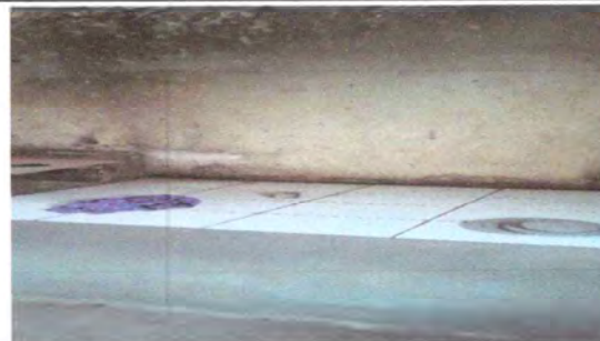
Foto 6: Sustrucción de piso en area de planchas de cocina
