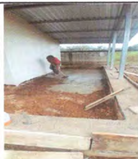
Foto 3: Sustrucción de piso de cocina ya que se encuentra muy quebrado
