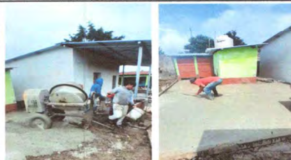
Foto 2: Reparación de losa de patio, ya que se encuentra muy dañada
