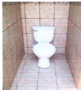
Foto 2: sustitución azulejo en baños
