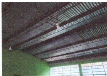
Foto 5: Reparación Sistema Eléctrico
