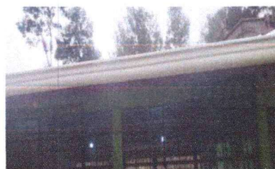
Foto 6: Cambio de Canales
