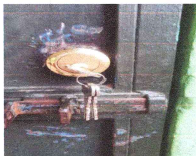
Foto 4: Reparación de Chapas
