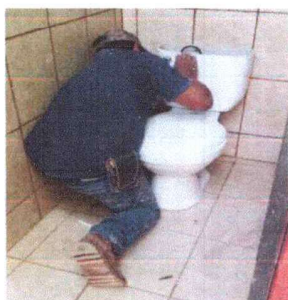
Foto 3: cambio de baños
