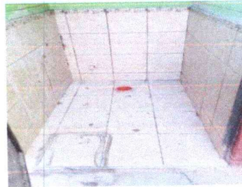
Foto 2: Colocacion azulejos baños
