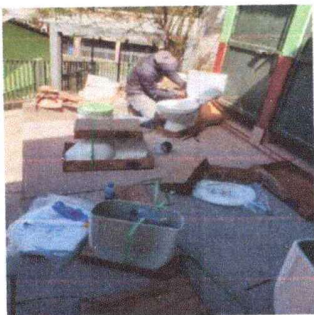
Foto 3: Sustitución de baños
