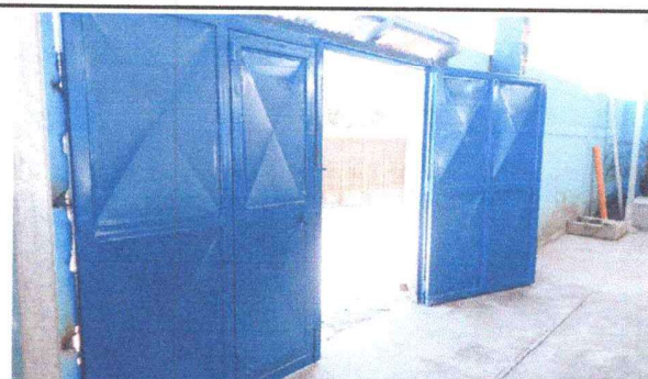
Foto 4: SUSTITUCIÓN DE PORTON DE TUBO CON LÁMINA LISA (3X2)
