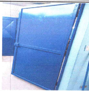
Foto 2: REPARACIÓN Y MANTENIMIENTO PUERTAS EN AREA DE AULAS
