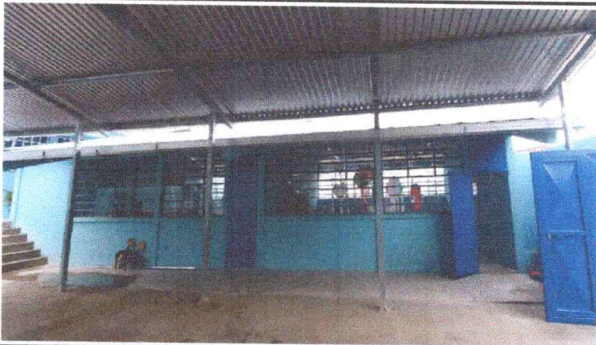
Foto 3: SUSTITUCIÓN DE CANALES Y BAJADAS 4"
