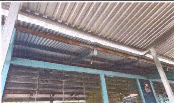
Foto 3: SUSTITUCIÓN DE CANALES Y BAJADAS 4"
