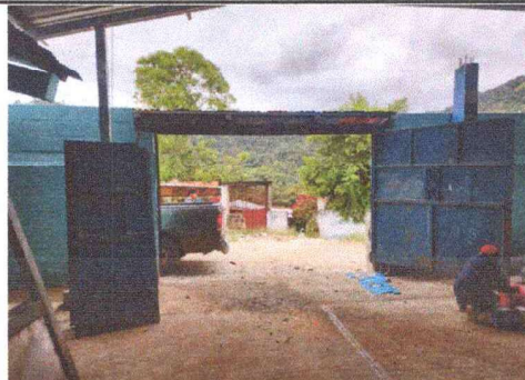
Foto 4: SUSTITUCIÓN DE PORTON DE TUBO CON LÁMINA LISA (3X2)
