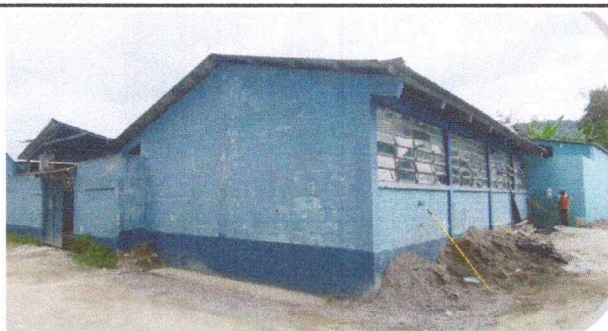
Foto 5: SUSTITUCIÓN DE PINTURA EN MUROS INTERIOR Y EXTERIOR
