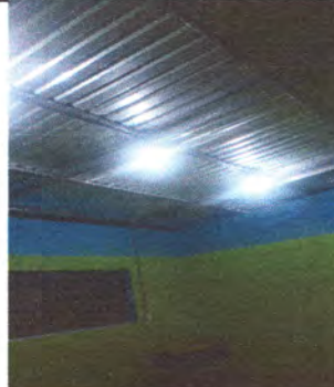
FOTO 2: Reparación sistema eléctrico
