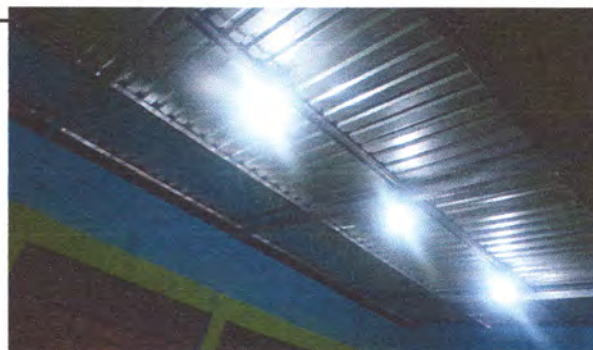
Foto: 6 Reparación de Sistema eléctrico
