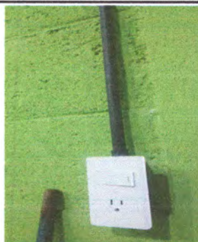
Foto4: Reparación de sistema eléctrico
