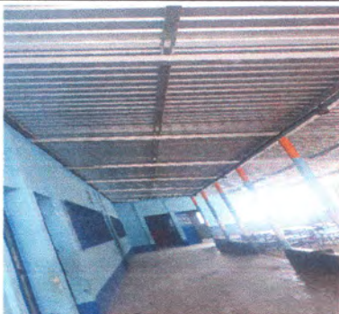
Foto1: Reparación estructura de techo
