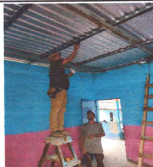
Foto: 6 Reparación de Sistema eléctrico
