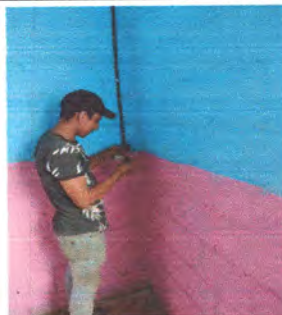
Foto4: Reparación de sistema eléctrico
