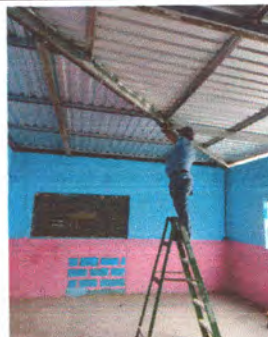
FOTO 2: Reparación sistema electrico
