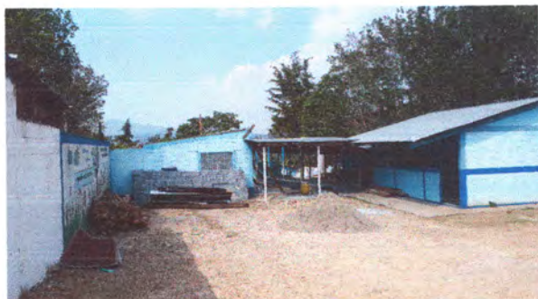
Foto3: Reparación Estructura de Techo
