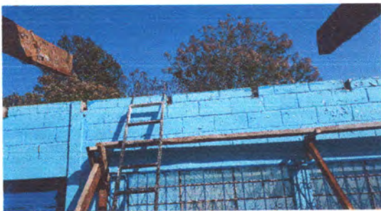
Foto1: Reparación estructura de techo
