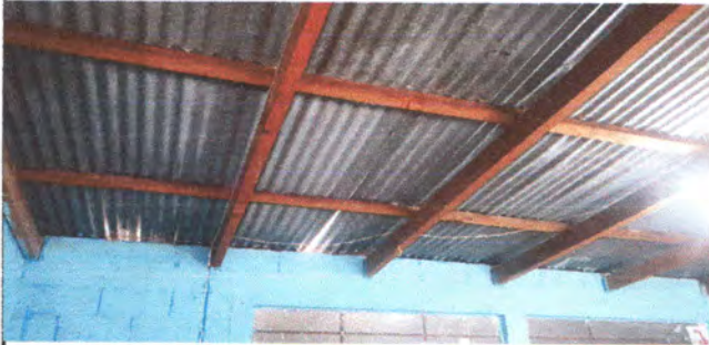
Foto1: Reparación estructura de techo
