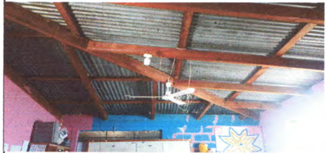
FOTO 2: Reparación sistema eléctrico
