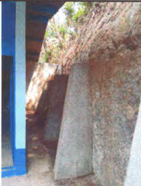
Foto3: Culminación de fundición de bases de soporte para muro de contención.
