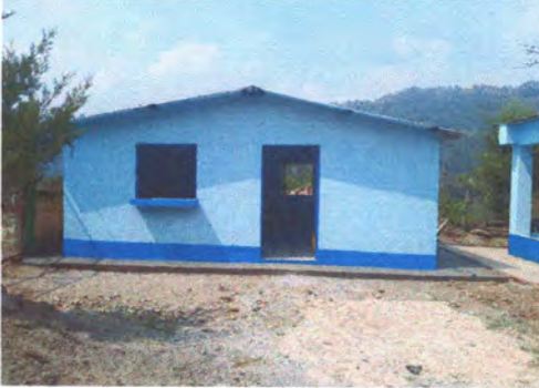
Foto1: Culminación de ampliación de cocina, instalación de estructura de metal, cubierta de lámina, sustitución de torta por piso de granito, reemplazo de estufas rurales, instalación y sustitución de puertas y ventanas.
