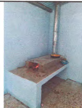
Foto4: Culminación de sustitución de estufas rurales.
