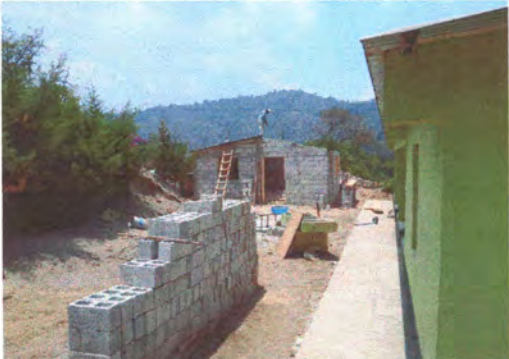
Foto 7: Colocación del techo al área de cocina que se remodeló.
