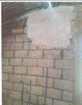
Foto 9: Sustitución del cernido de la cocina.
