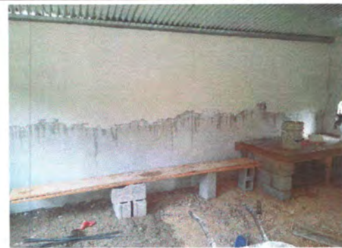
Foto 10: Proceso de sustitución de cernido.
