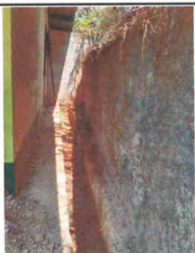
Foto: 5 Preparación de base para la fundición de soportes a muro de contención.
