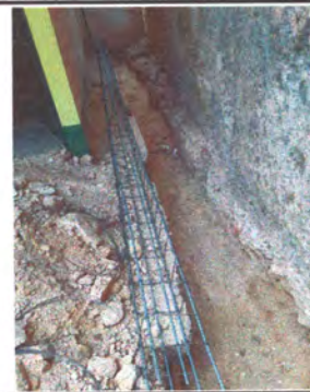
Foto: 6 Colocación de estructura de hierro para la base de soportes a muro de contención.
