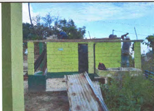
Foto1: Demolición de techo de cocina.
