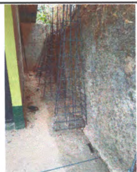
Foto 11: Instalación de bases de hierro como soportes al muro de contención.
