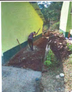
Foto3: Reemplazo de losa en mal estado.
