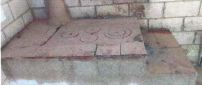
Foto1: Sustrucción de estufas rurales en mal estado.
