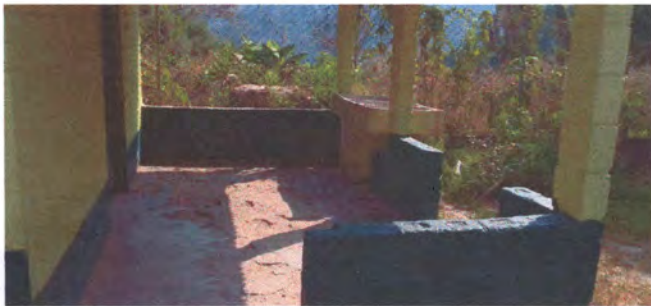
Foto3: Reemplazo de torta de cemento por piso de granito,
