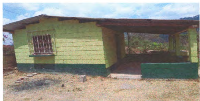
Foto: 5 Ampliación de cocina y cambio de techo por estar en mal estado.
