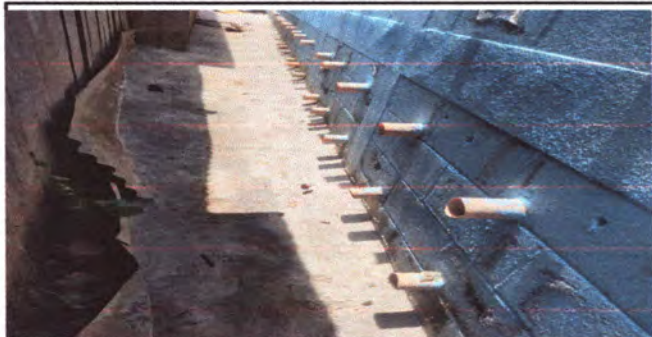
Foto1: Cuneta de concreto
