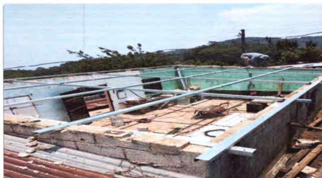
Foto4: soldadura de estructuta metalica
