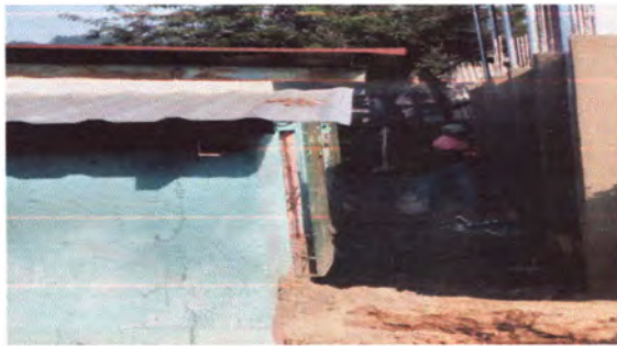
Foto3: Ultimos detalles a la reconstruccion del muro
