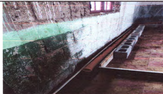
Foto: 6 Instalación de tubos.
