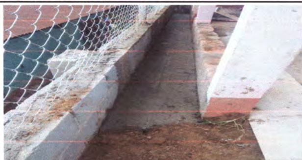
Foto3: Cuneta de concreto.
