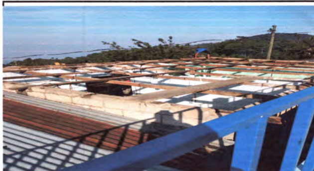
FOTO 2: Iniciando a retirar la estructura de techo.
