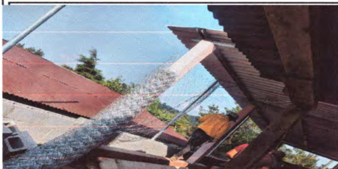
Foto1: Iniciando a instalar la malla metálica
