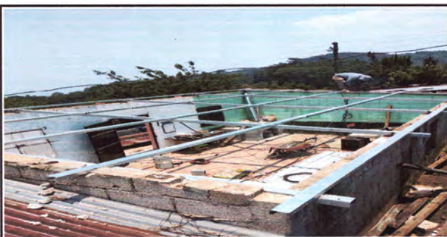
Foto3: colocación de estructura metalica.
