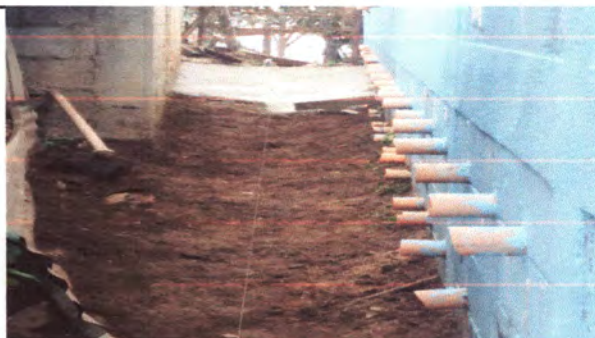
Foto 4: Iniciando la cuneta de concreto. Salida del agua
