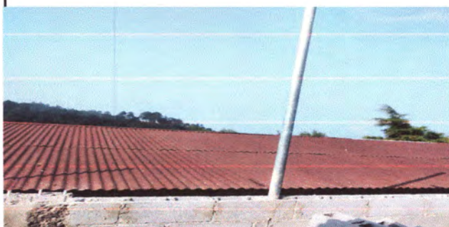
Foto: 6 fundicion de tubos para la malla.
