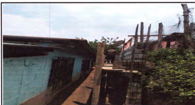
Foto: 6 Reconstrucción de muro.
