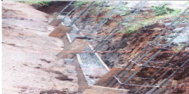
Foto1: fundiciones de reconstrucción
