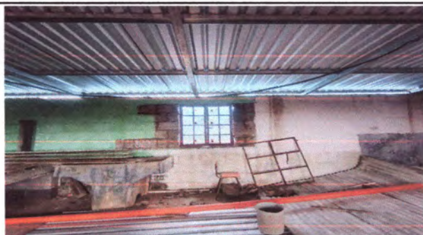
Foto: 5 Instalando ventanas
