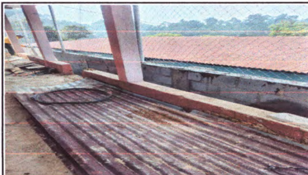
FOTO 2: Fundición de la malla
