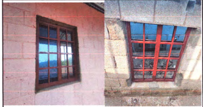
FOTO 2: instalacion de ventanas,
