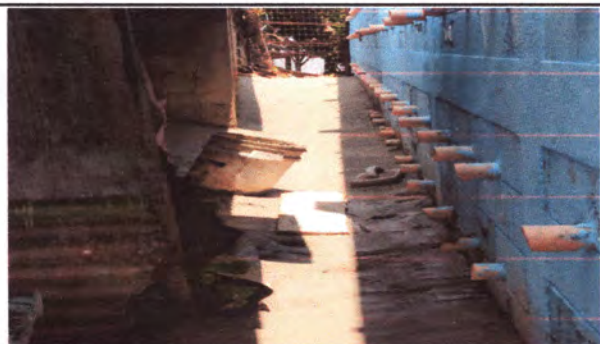
Foto: 5 cuneta de concreto casi finalizada.
