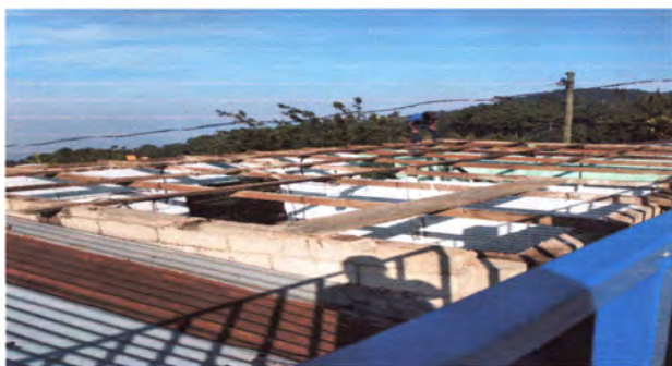
Foto1: Retirando la lamina vieja.
