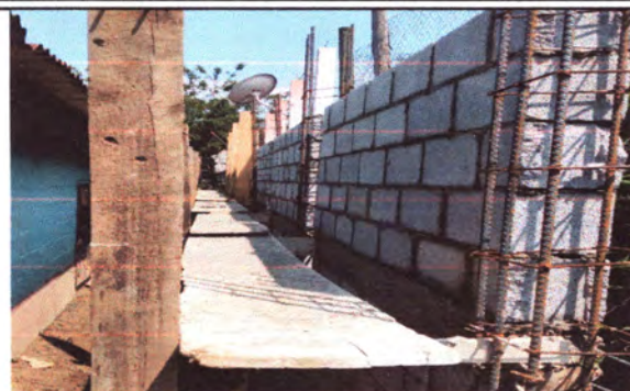
foto 2. Reconstruccion muro en un 70%.
