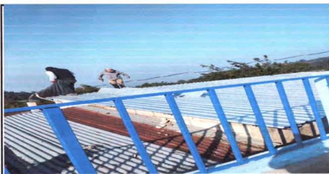
Foto: 5 colocacion de la lamina,
