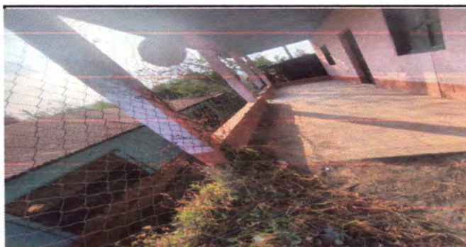
Foto3: Cambio de maya metalica.
