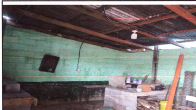
FOTO 2: Cambio de estructura de techo para cocina.
