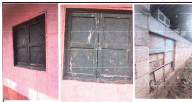
Foto4: cambio de 3 ventanas.
