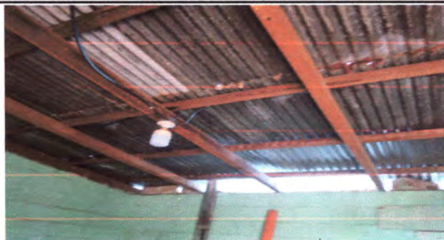
Foto1: Cambio de techo en la cocina
