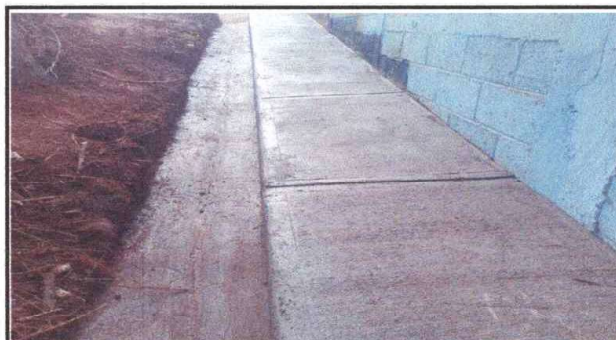
Foto 6: Reparación de cuneta de concreto finalizado
