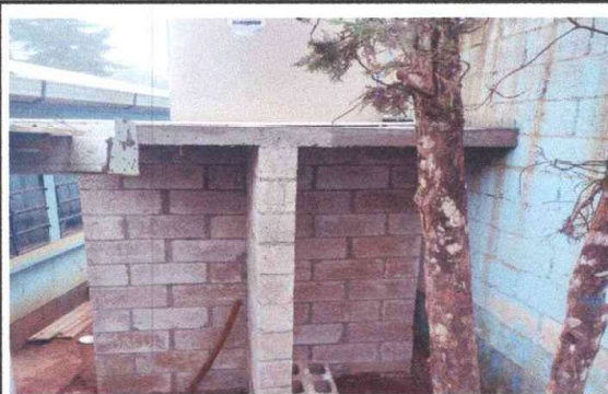
Foto 4: Renglón de reparación y mantenimiento de sisternas finalizado
