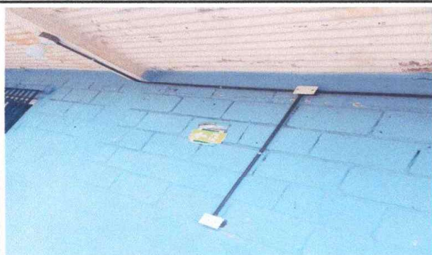
Foto 3: Reparación de sistema eléctrico finalizado
