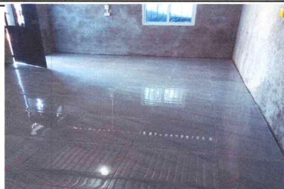
Foto 2: Sustitución de piso completado
