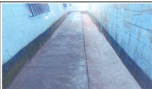
Foto 5: Renglón de cuneta de concreto finalizada
