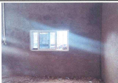
Foto 5: Reparación de repello en aulas completado
