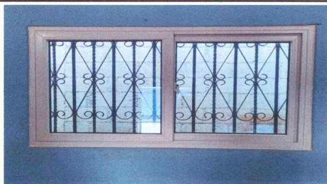
Foto1: Instalación de ventanas completo
