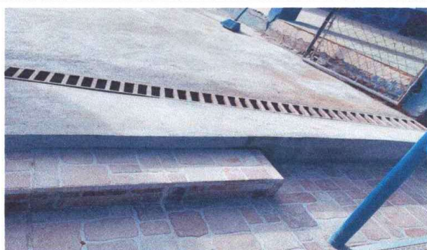
Foto 3: Reparación de bajadas de agua
