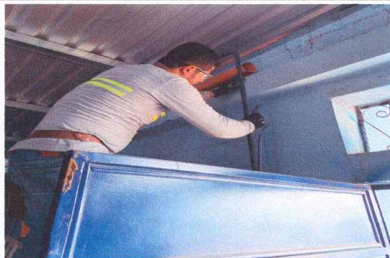
Foto1: Trabajando en reparación de sistema eléctrico
