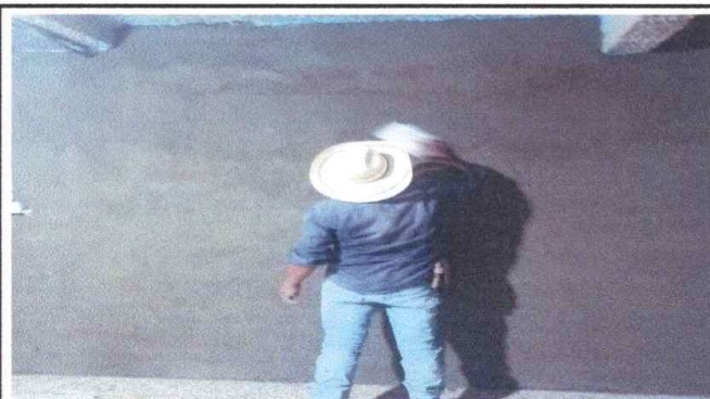
Foto 3: Trabajando en Repello de paredes
