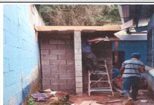
Foto 2: Trabajando en Reparación de base de sisterna
