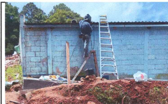
Foto 4: Trabajando en instalación de canal
