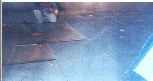
Foto 2: Instalación de nuevo piso
