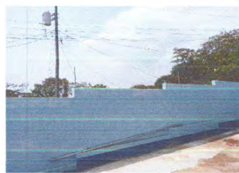
Foto4: PINTURA EN MUROS INTERIOR Y EXTERIOR
