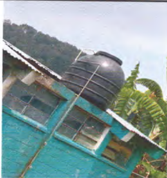
Foto 7: REPARACION Y MANTENIMIENTO DE CISTERNAS/ DEPOSITO DE AGUA
