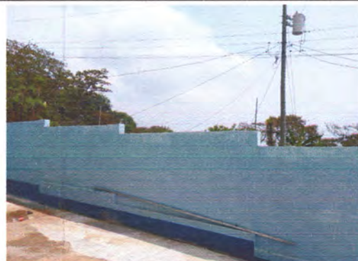
Foto4: PINTURA EN MUROS INTERIOR Y EXTERIOR
