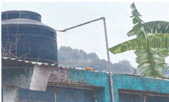
Foto 7: REPARACION Y MANTENIMIENTO DE CISTERNAS/ DEPOSITO DE AGUA
