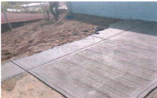
Foto: 5 LOSA DE PATIO
