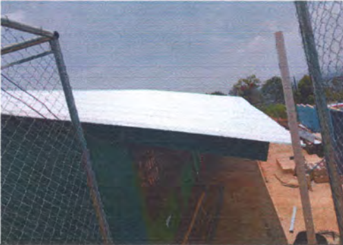
Foto1: CUBIERTA DE LAMINA
