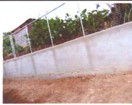
Foto4: PINTURA EN MUROS INTERIOR Y EXTERIOR
