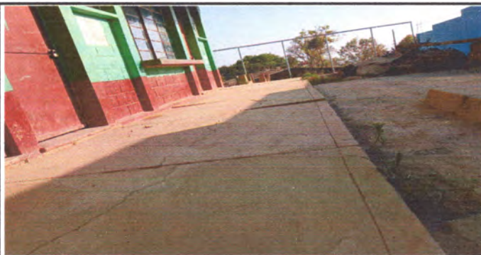
Foto: 5 LOSA DE PATIO
