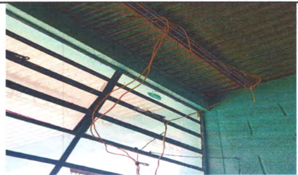
Foto: 6 REPARACION DE SISTEMA ELECTRICO
