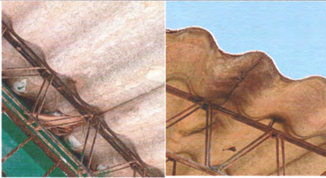
Foto1: CUBIERTA DE LAMINA
