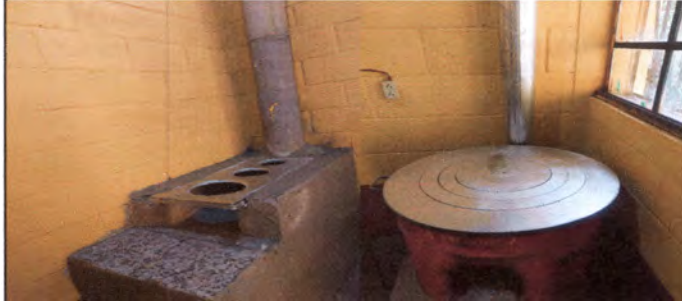
Foto 11: Reparación de área de cocina.
