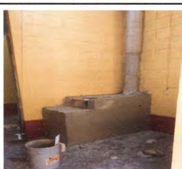
Foto 11: REparación o sustitución de cocina.
