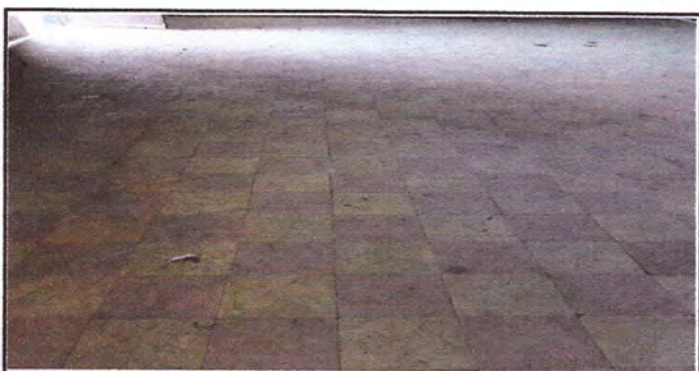
Foto 5: Sustrucción de piso
