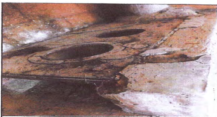
Foto 11: Reparación de cocina
