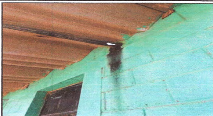
Foto 2: Estructura de techo
