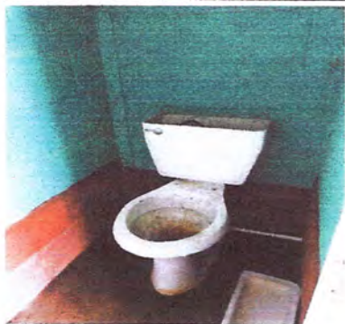
Foto 7: Sustitución de baño
