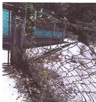
FOTO 8: Sustitución y mantenimiento de portones
