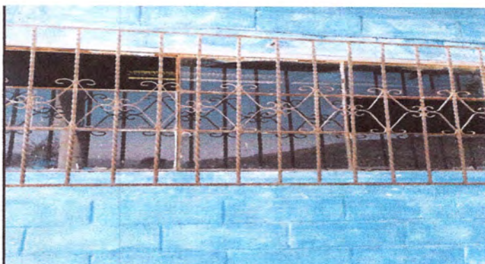
Foto 4: Sustrucción de ventanas
