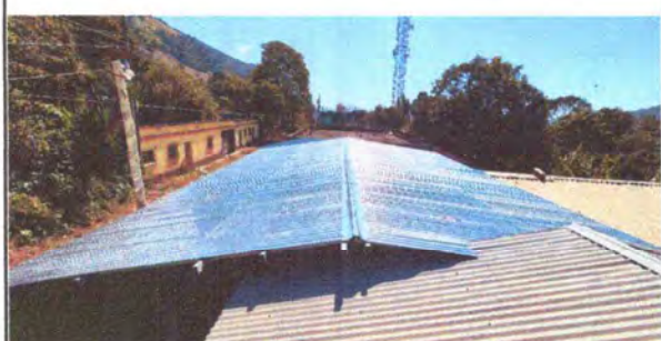
Foto1: Sustitución de lámina acanalada legitima y capote del patio del corredor para actividades
