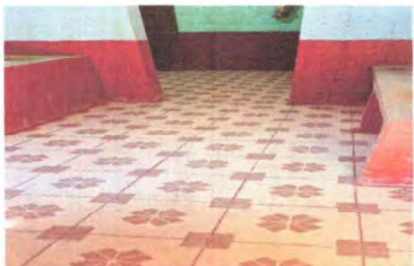
Foto 3: Sustitución de piso antideslizante del área de cocina
