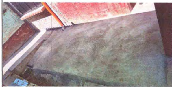
Foto 8: Reparación de losa de patio
