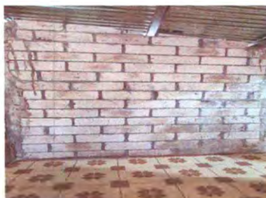
Foto 6: Sustitución de pared con block que divide la cocina con aula (al norte del centro educativo)
