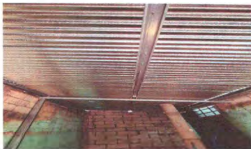
Foto 11: Sustrucción de estructura de techo de parte de la cocina
