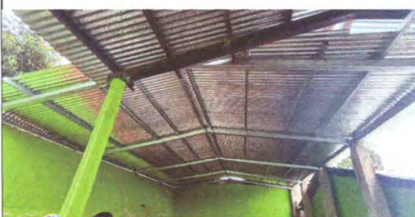
Foto 2: Sustitución de estructura de techo del patio techado para actividades
