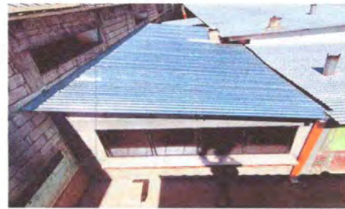
Foto 10: Sustrucción de lámina acanalada legítima calibre 28 de parte de la cocina
