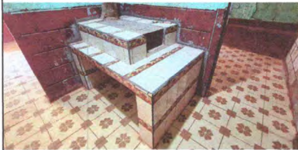
Foto 4: Sustitución de Azulejo de planchas de cocina
