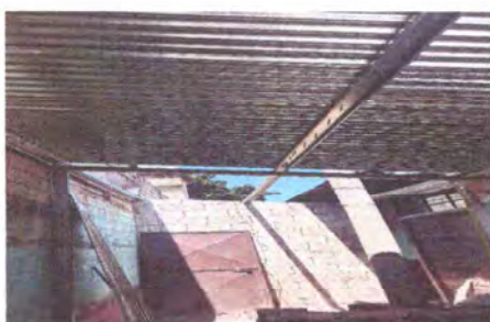
Foto 11: Sustitución de estructura de techo de parte de la cocina.
