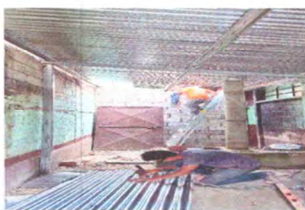
Foto 10: Sustitución de lámina acanalada legitima calibre 28 de parte de la cocina
