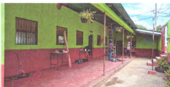
Foto 9: Sustitución de cableado, tomacorrientes y bombillas led con interruptor
