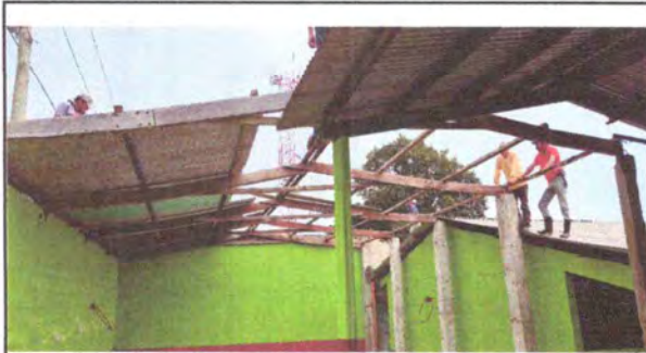
Foto 1: Desmontaje de cubierta de lamina como de estructura de madera
