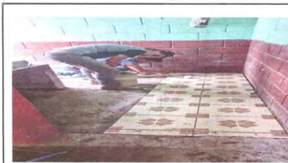
Foto 3: Sustitución de piso antideslizante del área de cocina
