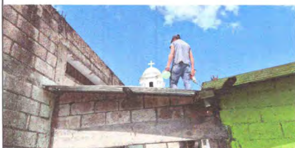
Foto7: Sustitución de canales y bajadas de agua fluvial de cocina
