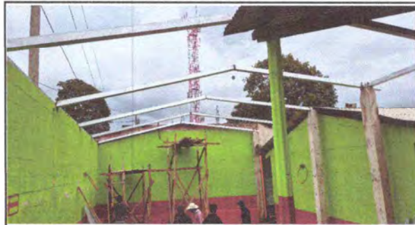
Foto 2: Sustitución de estructura de techo y lamina acanalada del techo del patio para actividades
