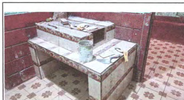
Foto 4: Sustitución de Azulejo de planchas de cocina
