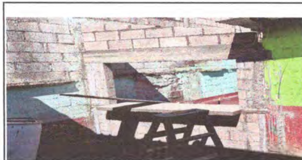
Foto 5: Sustitución de pared de block en el área de cocina (área de entrega de alimentos a los niños y niñas) al sur del centro educativo
