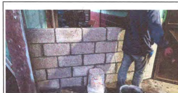
Foto 6: Sustitución de pared que divide la cocina con aula (al norte del centro educativo)
