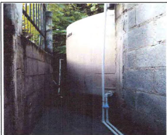
Foto 9: Reparación y mantenimiento de cisternas/deposito de agua
