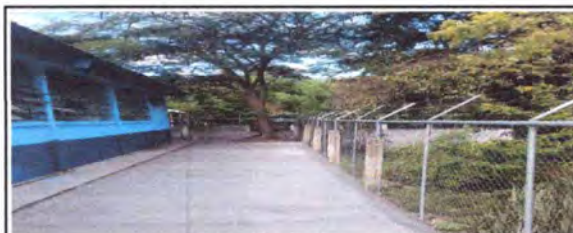
Foto 8: Losa de patio
