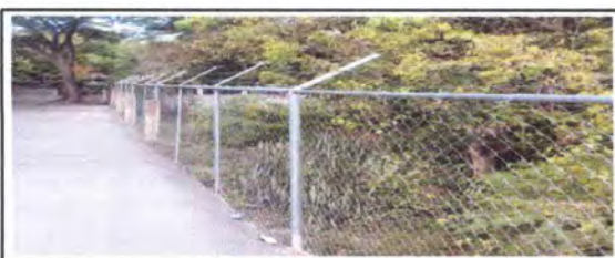
Foto 7: Cerco o muro perimetral
