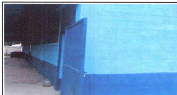
Foto 3: Pintura en muros interior y exterior
