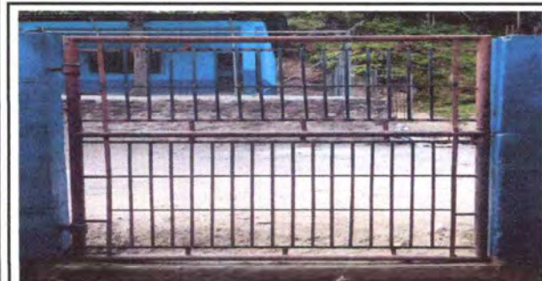
Foto 5: Mantenimiento a portones
