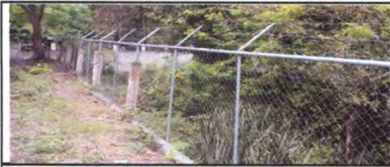
Foto 7: Cerco o muro perimetral
