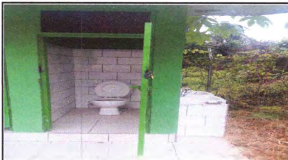
Foto 4: Servicios sanitarios y sus accesorios
