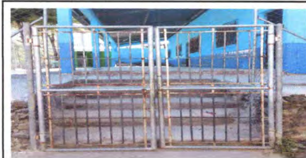
Foto 5: Mantenimiento a portones
