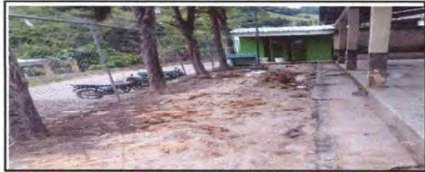
Foto 8: Losa de patio
