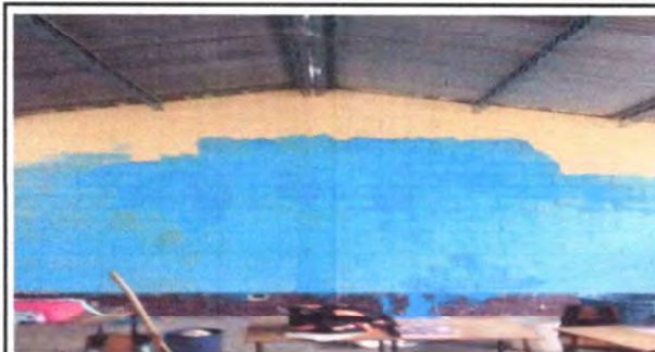
Foto 3: Pintura en muros interior y exterior
