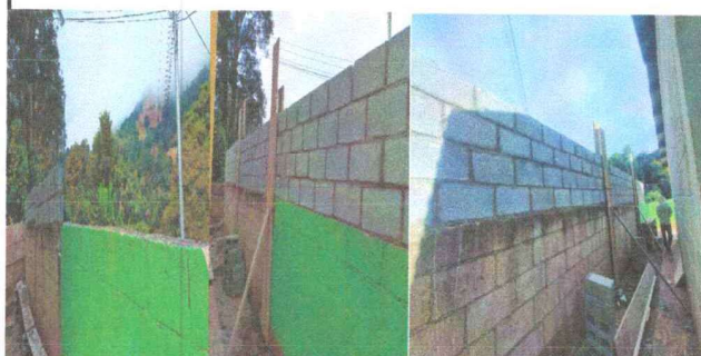
Foto 2: MEJORAMIENTO DE MURO PERIMETRAL
