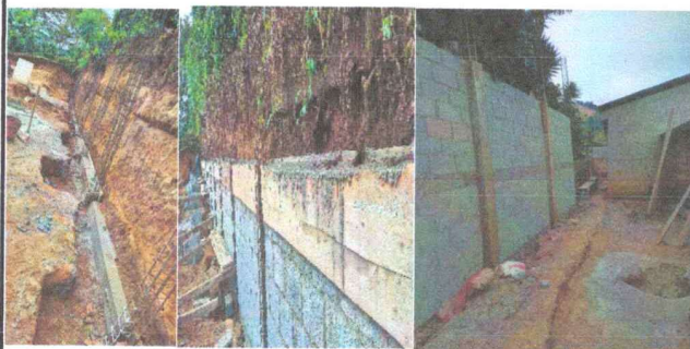
Foto1: SUSTITUCIÓN DE MURO PERIMETRAL
