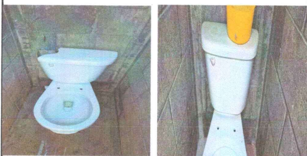
Foto 3: MANTENIMIENTO SERVICIOS SANITARIOS Y SUS ACCESORIOS
