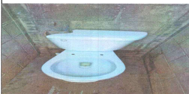
Foto 3: MANTENIMIENTO SERVICIOS SANITARIOS Y SUS ACCESORIOS
