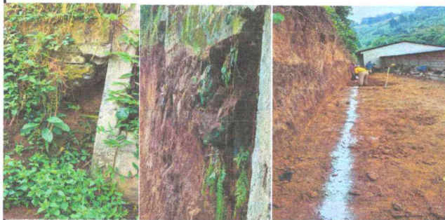
Foto1: SUSTITUCIÓN DE MURO PERIMETRAL
