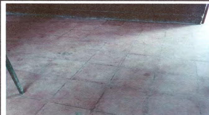
Foto 3: Sustitución de piso en aula
