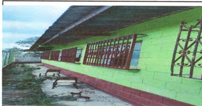
Foto 11: Avance pintura de exterior
