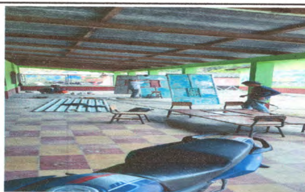
Foto 10: Avance en pintura de puertas
