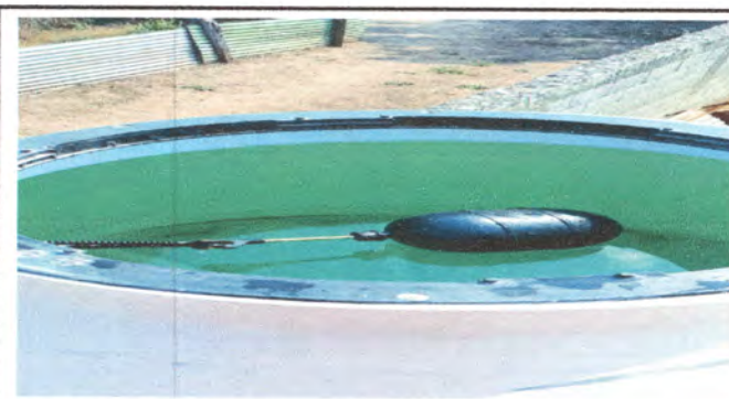
Foto 12: Avance deposito de agua (TINACO)
