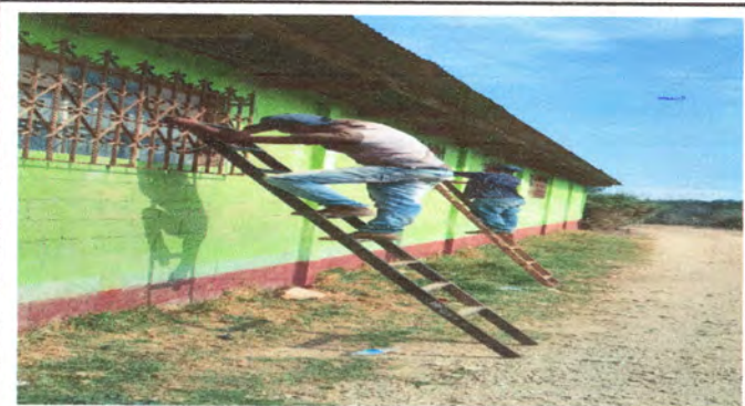
Foto 9: Avance de ventanas
