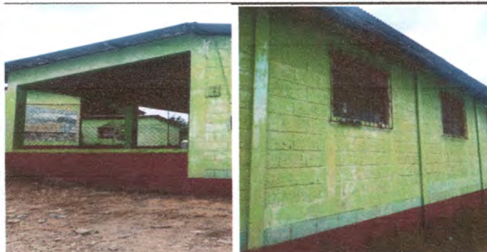
Foto 11: Pintura de interior y exterior
