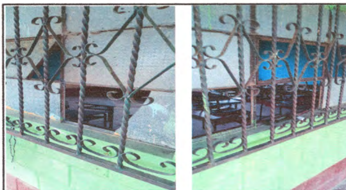
Foto 9: Reparación de ventanas y vidrios
