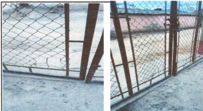
FOTO 7: Reparación del portón y pintarlo
