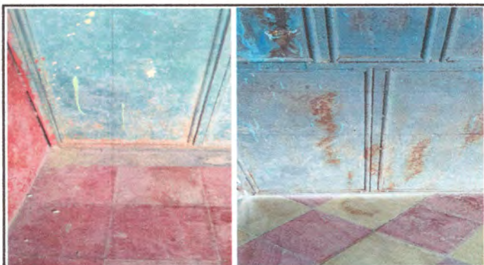
Foto 10: Reparación y pintura de puertas
