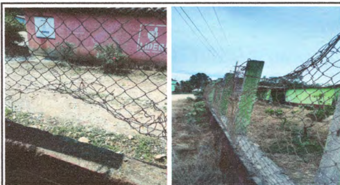
FOTO 8: Cambio de todo el cerco perimetral
