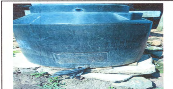
Foto 12 ; Sustitución de deposito de agua ( TINACO)
