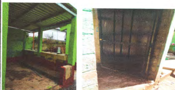
Reparación de cocinas, pilas y techo
