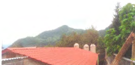
Reparación y mantenimiento de cisterna
