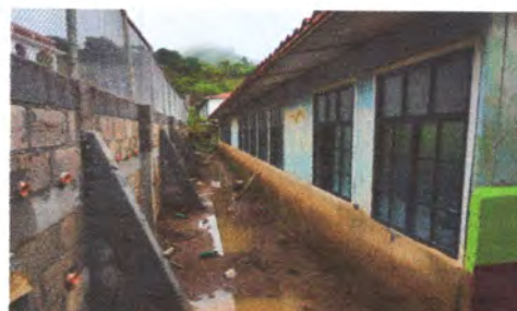
Reparación de muro de contención
