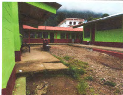
Reparación de ventanas
