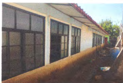
Reparación de balcones y puerta
